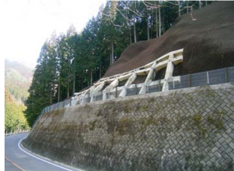
【法面防災対策】
