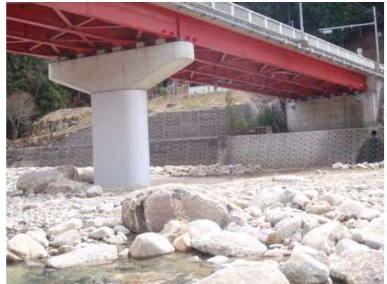
【橋梁下部工補強】
