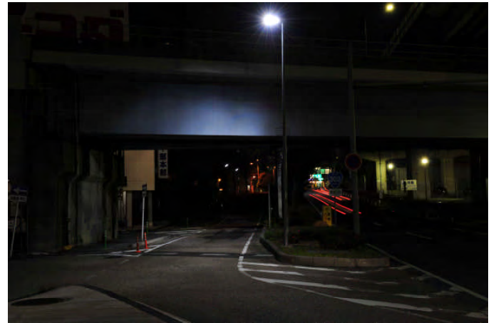
施工後(LEDランプ)
