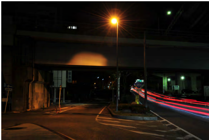
施工前(高圧ナトリウムランプ)
