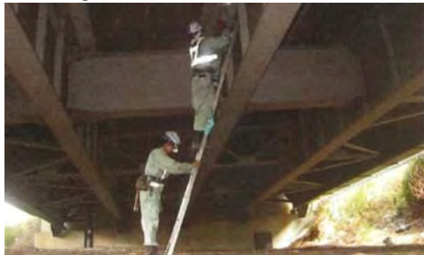
③職員による橋梁の点検のとりにくみ
