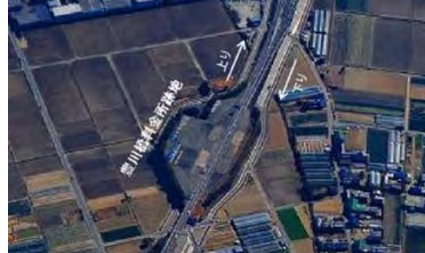
②国道23号豊橋バイパス緊急連絡路の整備
