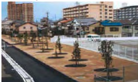
⑤国道23号環境施設帯整備
