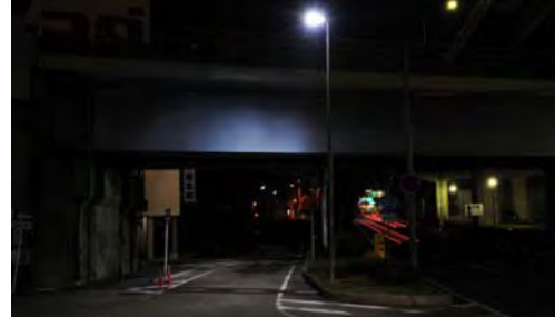
⑥LED道路照明とICT(情報通信技術)の活用
