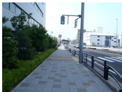
国道 1 号 星崎電線共同溝
