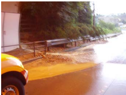
国道 19 号 北山法面崩落
