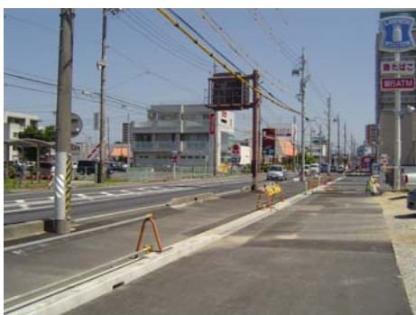
国道 153 号 陣中町 現道拡幅・電線共同溝事業
