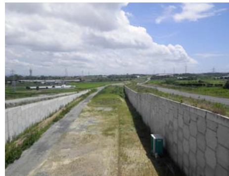
国道23号 豊橋東バイパス(細谷ICから上り方向)を臨む 平成24年8月現在状況
