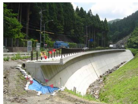
国道 153 号 明川地区避讓車線設置工事
