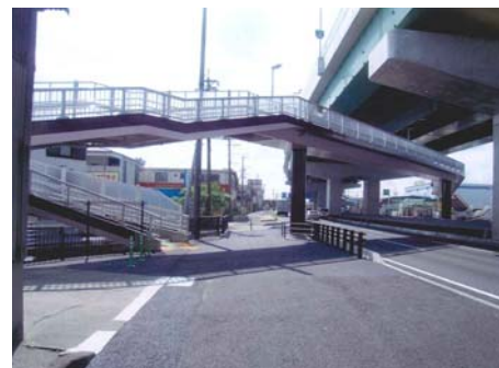
国道 22 号 伝法寺歩道橋
