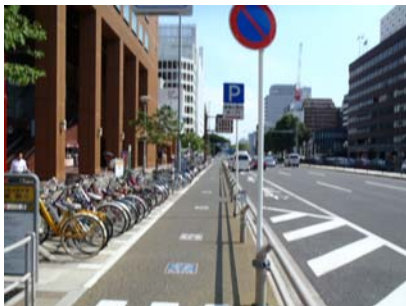
国道 19 号 伏見通自転車走行空間
