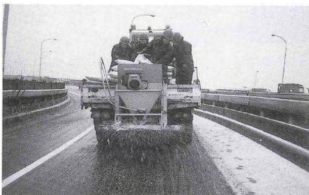
砂散布機による薬剤散布作業（昭和50年代）
