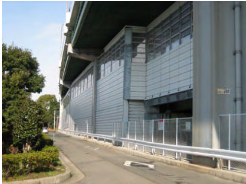
遮音壁設置状況
