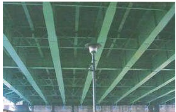
床版補強状況(増桁工法)
