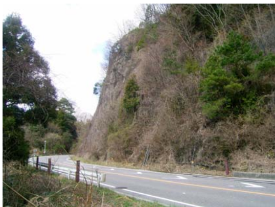
法面防災 対策前
