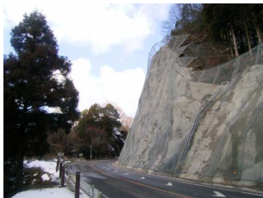
法面防災 対策後
