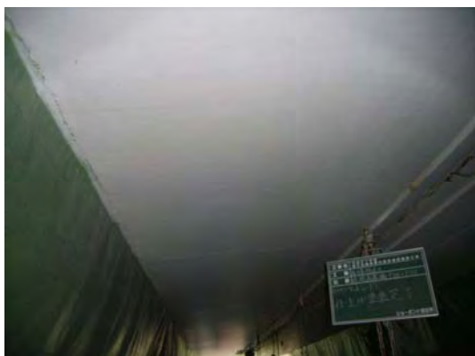
写真 床版の剥落防止対策
