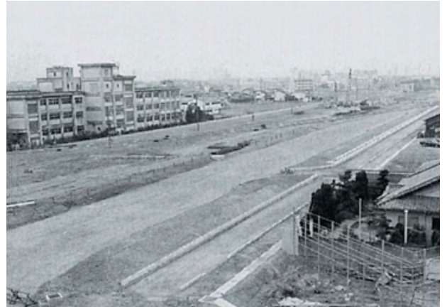
(昭和 52 年頃名古屋市西区の改良工事)
