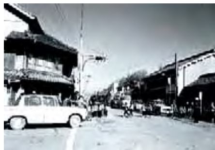
(昭和 38 年 豊田市に初めて設置された信号機)
