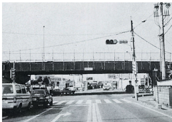
(昭和 50 年頃の犬山市五郎丸付近 写真高架部分が名濃バイパス)
