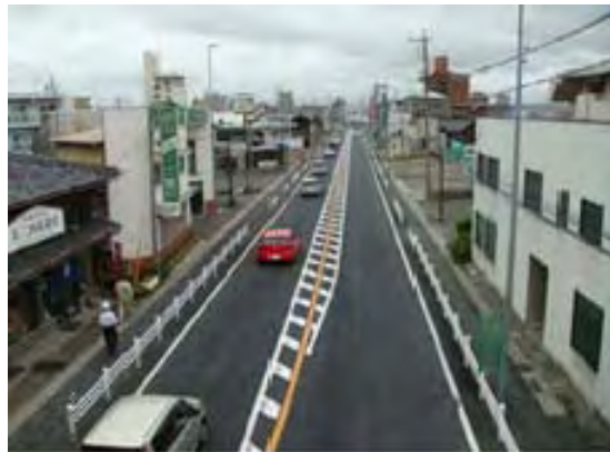
(国道 1 号西部環境対策)(下之一色区間)
