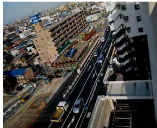
(高杉町～下之一色町間の工事状況)
