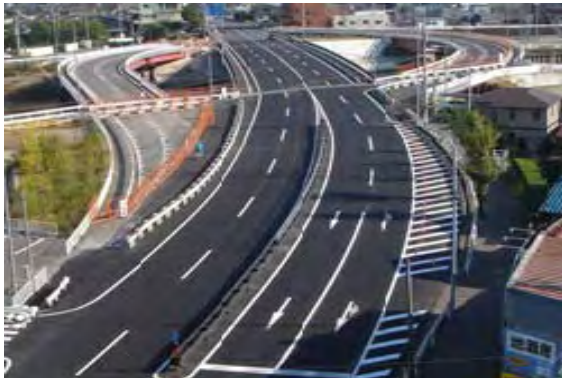
(国道 1 号大慶橋架替工事)
