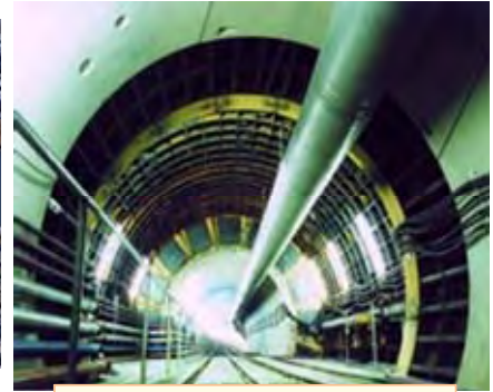
(2009年 国道19号春日井共同溝)
