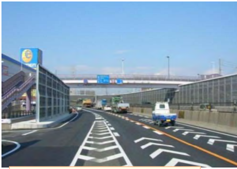
(2007年 国道23号名四横断歩道橋)
