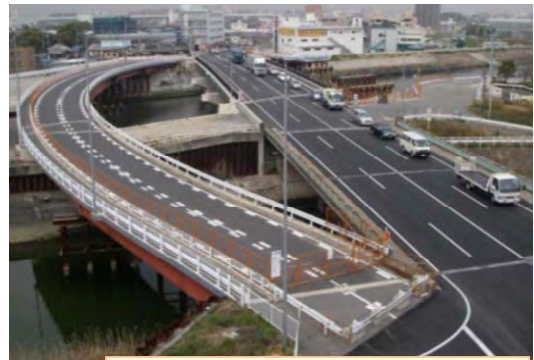
(2006年 国道1号大慶橋架替工事完成)
