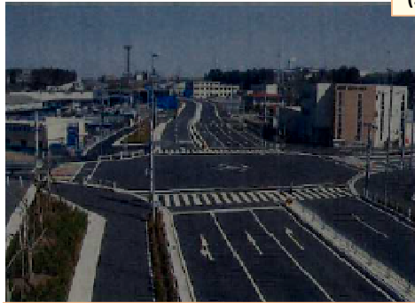
(2004年 国道155号鴻ノ巣交差点改良完成)
