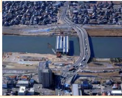
(2008年 国道1号一色大橋架替工事)
