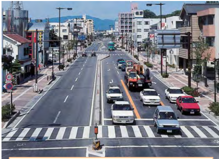
(1991年 国道153号豊田拡幅事業完成)
