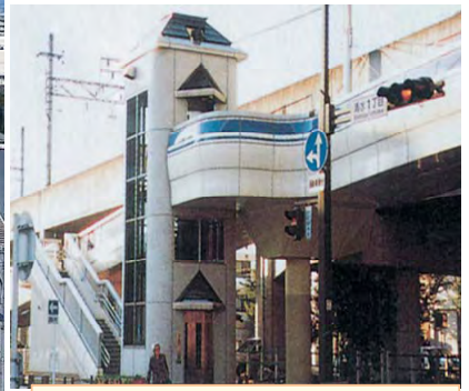
(1998年 国道41号清水横断歩道橋)
