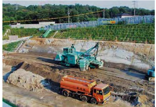
(2001年 国道153号勘八地区改良工事)
