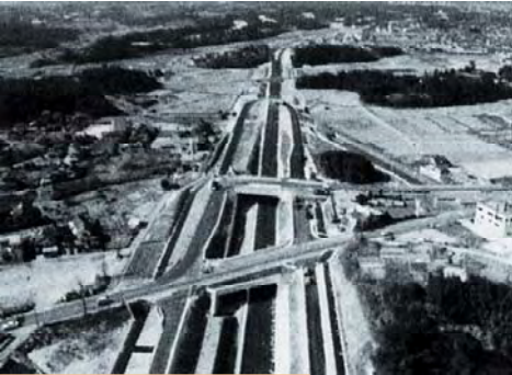
(1980年 国道153号 豊田西バイパス供用開始)
