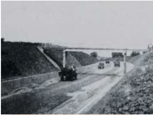
(1955年 国道1号豊明新道改良工事)
