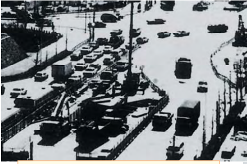
(1979年 国道22号丸の内共同溝着手)
