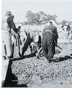
(コンクリート舗装施工状況)
