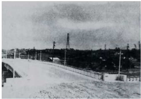
(1953年 国道1号大慶橋・汐見橋架替工事着手)
