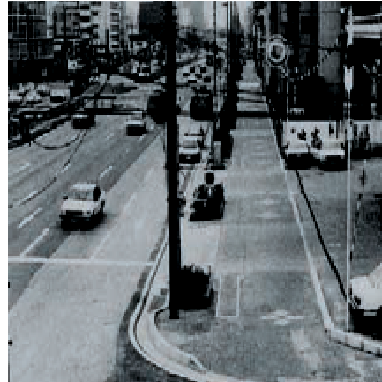
(1986年 国道41号高岳キャブ工事着手)
