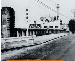
架替前の昭和橋
