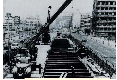
(1970年 国道19号桜共同溝着手)
