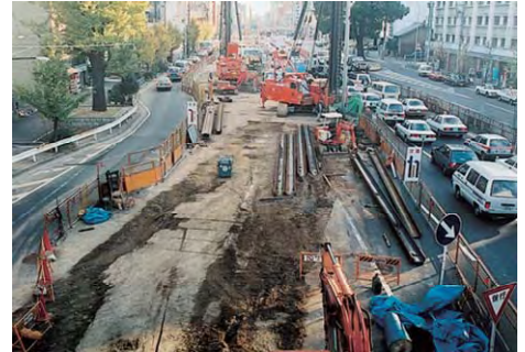
(1989年 国道41号清水(I)共同溝着手)
