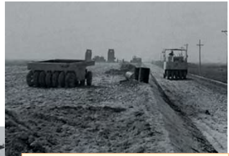
(1962年 国道22号名岐ハイパス改良工事)
