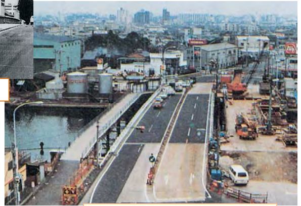
(1981年 国道1号昭和橋架替工事)
