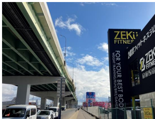
電線・電柱撤去後 令和 7 年 2 月撮影
