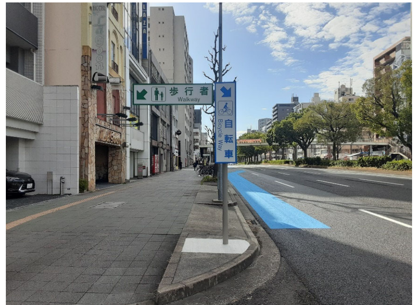
通行区分標識の整備
