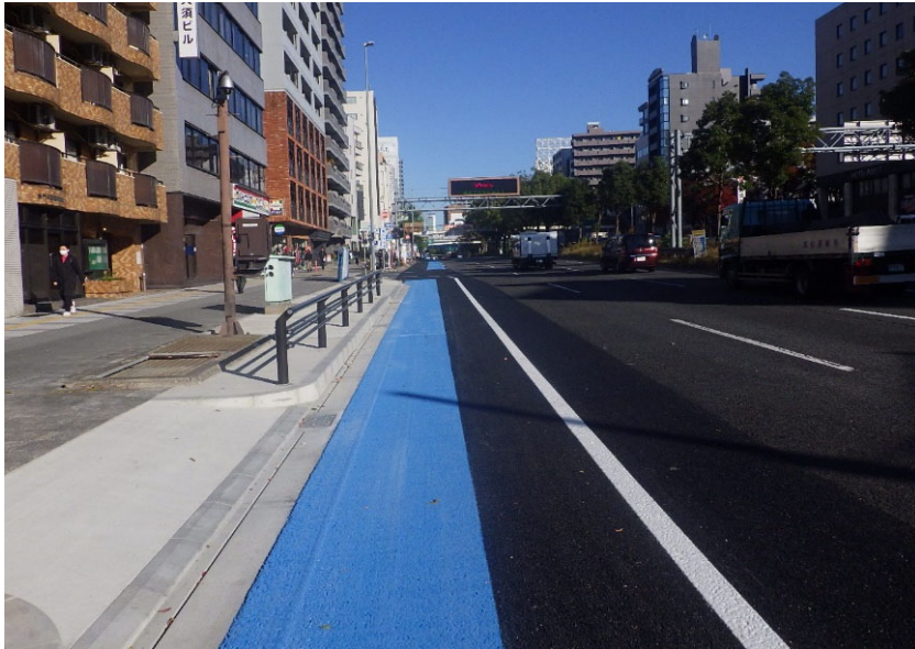
縁石・側溝と自転車レーンの整備
