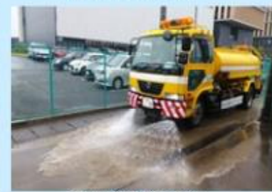
路面清掃状況
