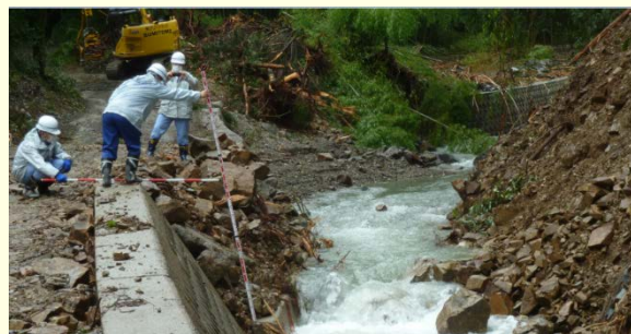
被災状況調査の様子
