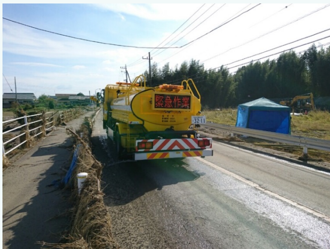
被災地での作業状況(10月17日茨城県常陸大宮市内)
