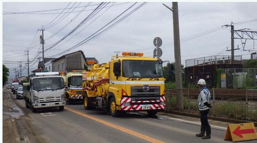
被災地での作業状況(9月2日佐賀県武雄市朝日町)
