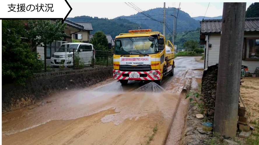
散水による清掃作業(7月15日愛媛県西予市)
