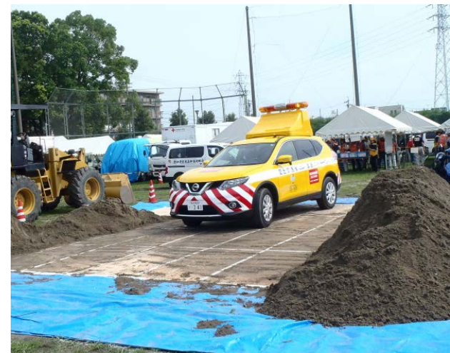
道路啓開後、パト車で安全を確認
