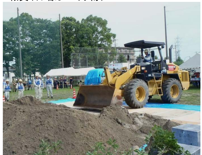
シャベルローダーで道路啓開を実施
