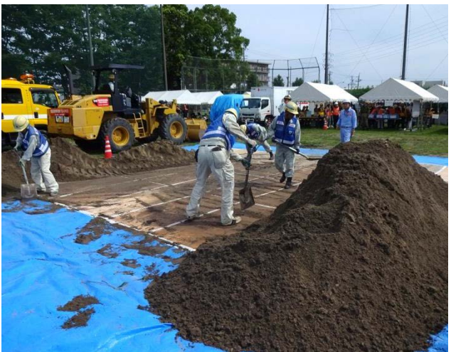
5m幅で道路啓開を完了
