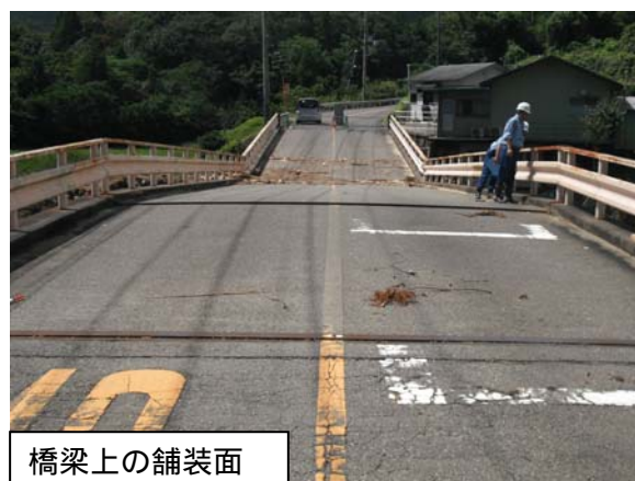
河川の増水(洗掘)により沈下した橋梁
