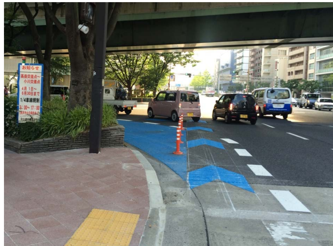
○左折時巻き込み事故防止対策(路面表示+ポストコーン)
