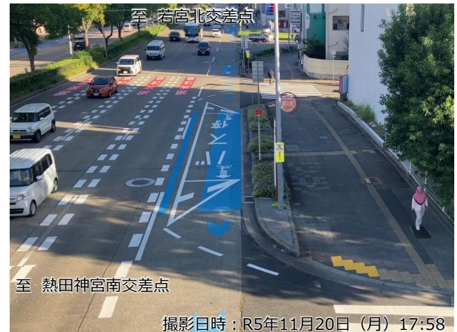
<写真④> バス停部の自転車専用通行帯
