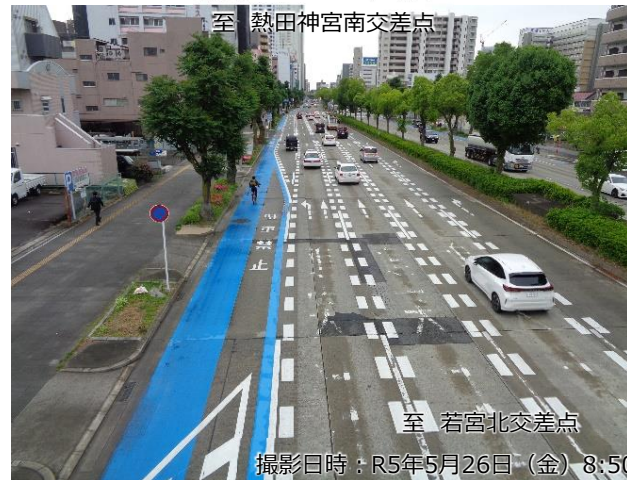
<写真③> 単路部の自転車専用通行帯
