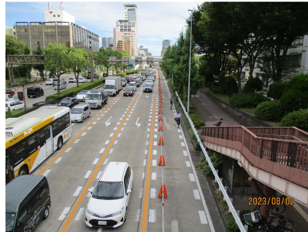
写真②：A型バリケード設置状況
