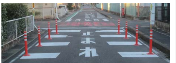
<狭さく設置状況>
