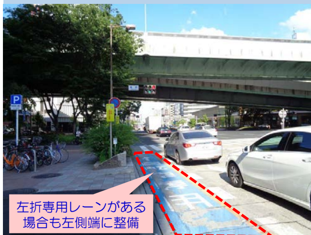
整備事例：国道41号 高岳交差点
