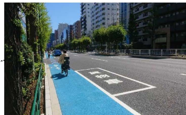
都道301号 (白山通り) ※自転車通行帯の車道側に停車帯を設置
