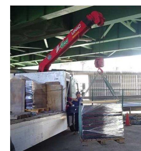
⇒ユニック車で運搬
