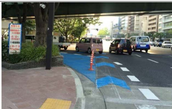
【高岳交差点上り】左折時巻き込み事故防止対策 (路面標示+ポストコーン)
