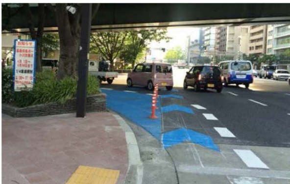
【高岳交差点下り】左折時巻き込み事故防止対策 (路面標示+ポストコーン)
