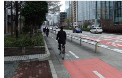
自転車道(双方向通行) H23.6.23供用
