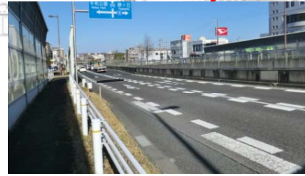
減速路面標示(ドットライン)
