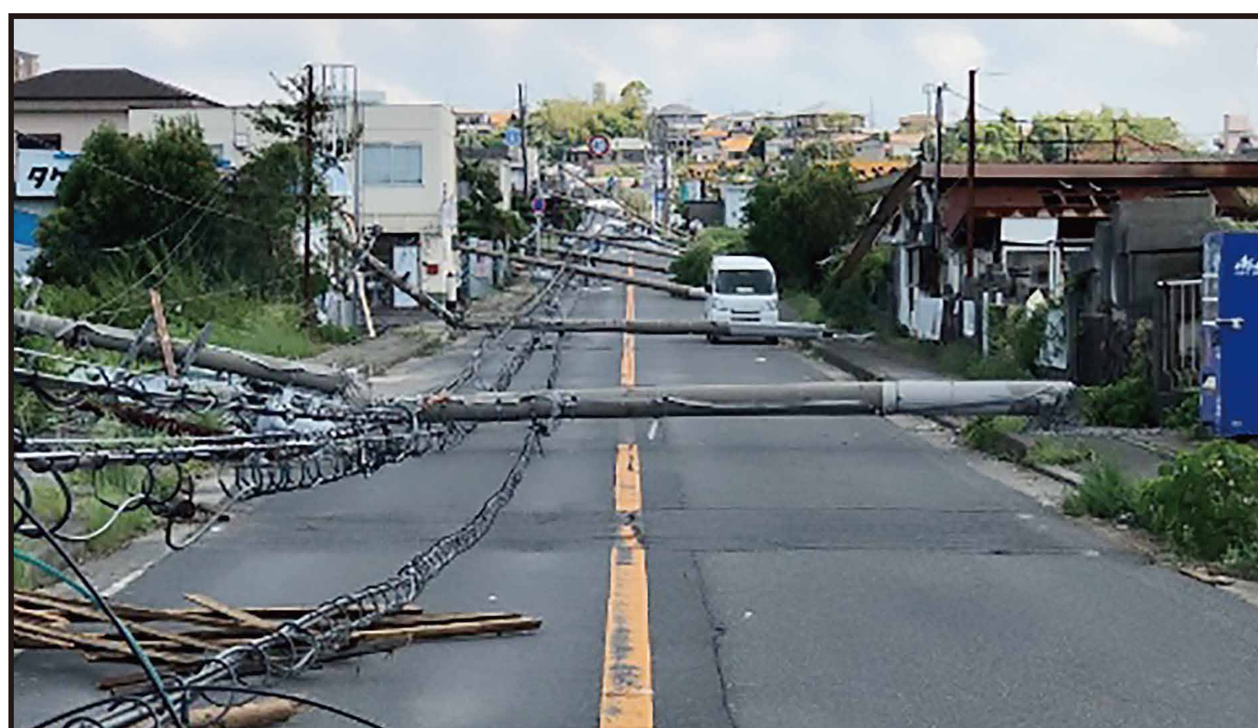
【令和元年9月 台風第15号 千葉県館山市(県道：館山富浦線)】 千葉県を中心に約2,000本の電柱が倒壊 ※国土交通省調べ
