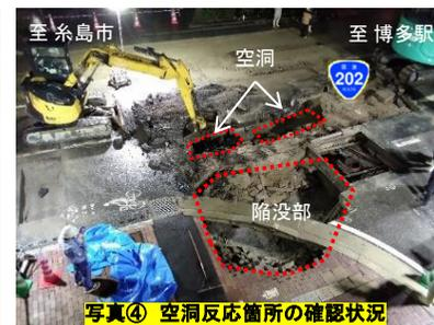
写真④ 空洞反応箇所の確認状況
