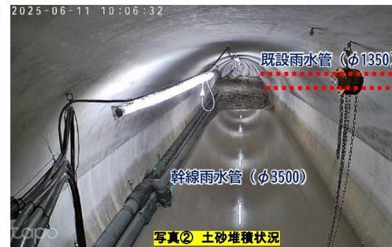
写真② 土砂堆積状況
