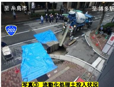
写真③ 流動化処理土投入状況
