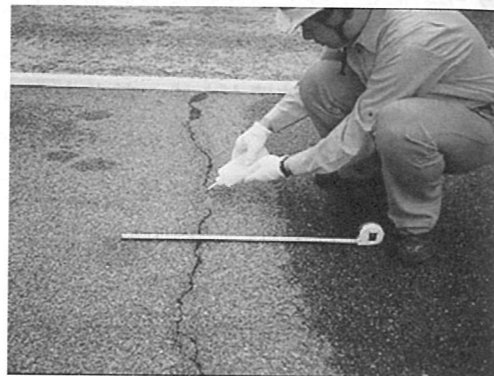
写真-4.2.12 樹脂系シール材の施工状況
