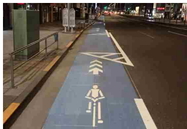
(国道246号:青山地区)
