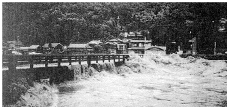
桁下高不足による支障事例
