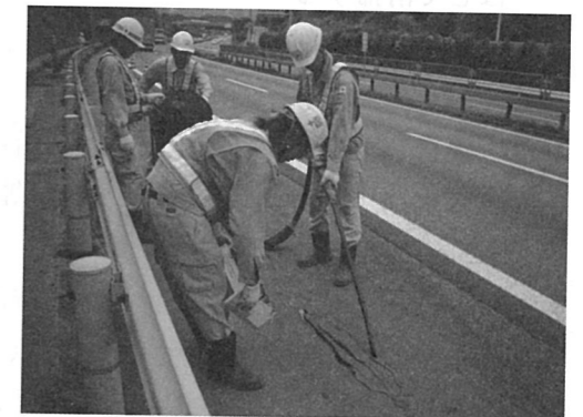
写真-4.2.10 シール材注入状況
