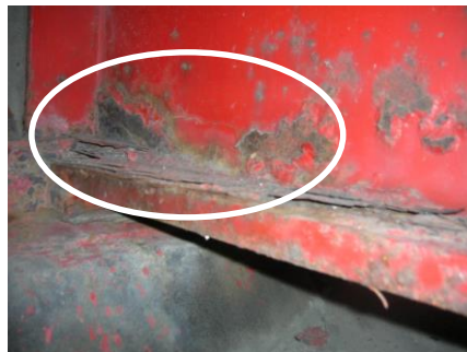
主桁の腐食
