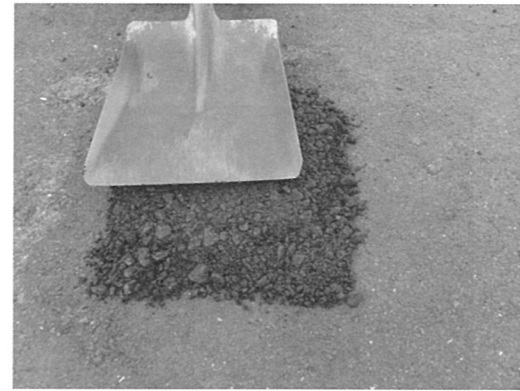
写真-4.2.9 スコップによる締めめ状況
