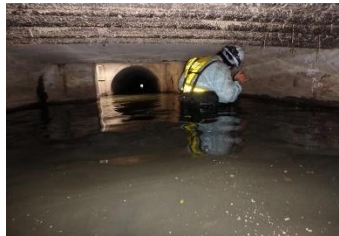
滞水した溝橋内部の目視点検
