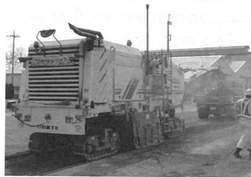
写真-4.2.13 路面切削機による切削状況
