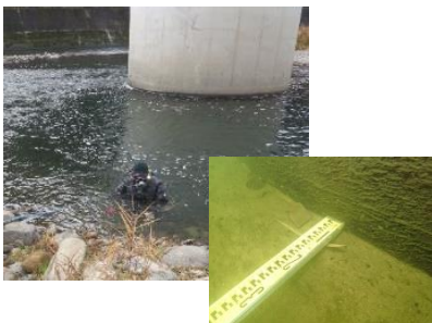
潜水調査による河床洗掘の把握
