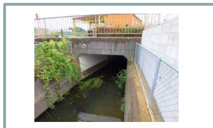
■ 溝橋(ボックスカルバート)
