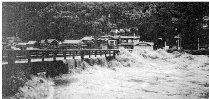
桁下高不足による支障事例
