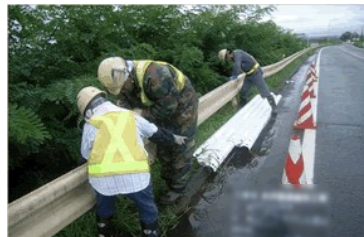
<防護柵の取替>
