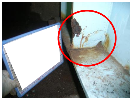
主桁の腐食
