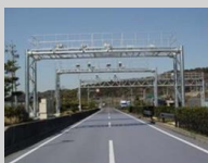
WIM(自動計測装置)による取締り
