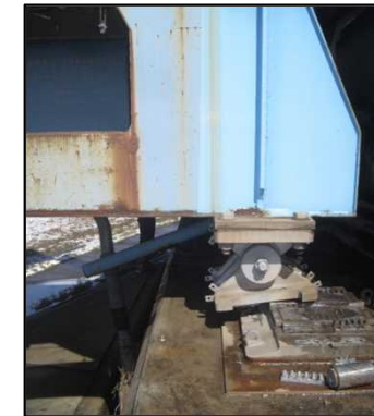
A1支承（可動）： 上部構造の移動に伴いローラーから脱落
