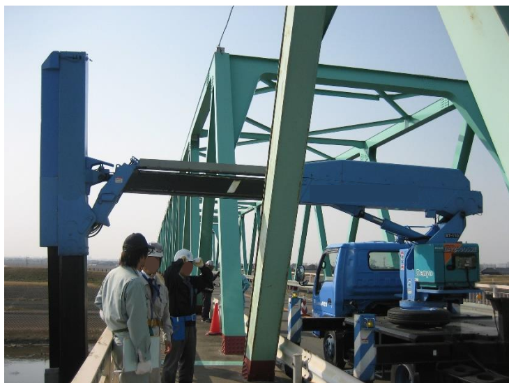
部材間の隙間を狙ってアームを通すのが手間であるトラス橋やアーチ橋
