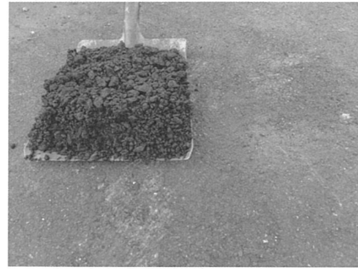
写真-4.2.8 常温全天候型施工前状況
