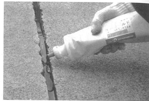
写真-4.2.11 シール材注入状況
