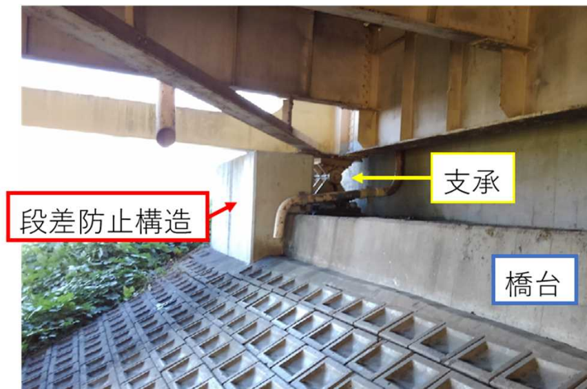
主桁下面の支承前面に設置した例
