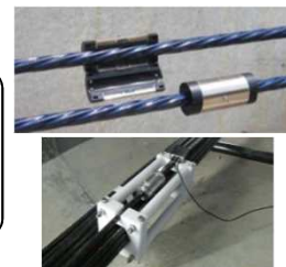
センサーによる橋梁ケーブル張力のモニタリング
