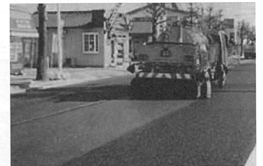
写真-4.2.14 フォグシール施工状況
