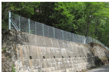
<落石防止柵の取替>
