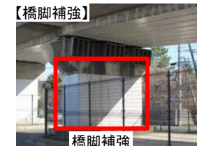
落橋防止構造
