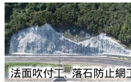
法面吹付工、落石防止網工
