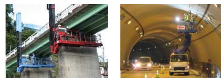
橋梁点検 (点検車) トンネル点検
