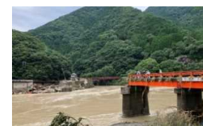
熊本県道の被害状況
