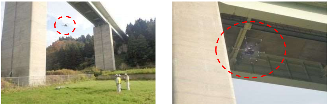
図II-9 ドローンによる点検状況
