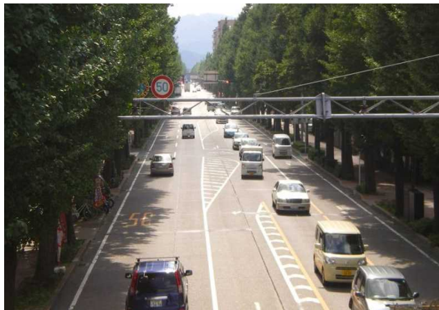
国道20号 八王子市追分町交差点付近（甲府方向へ撮影）
