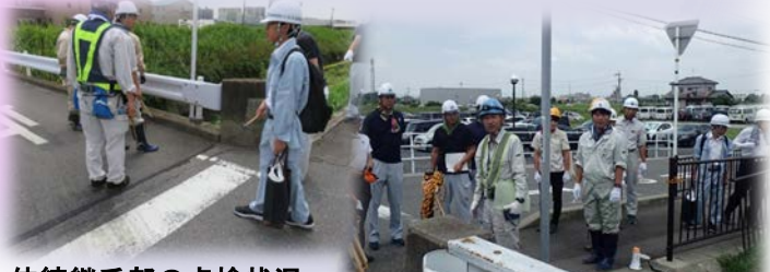
伸縮継手部の点検状況
