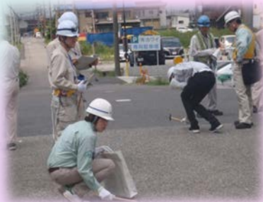
舗装面のひび割れ等の損傷を確認
