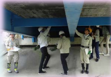
床版の損傷等を確認
