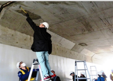
打音検査の様子(函渠)
