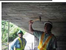
目視及びハンマーによる打音検査
