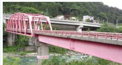
＜音沢橋の状況＞
