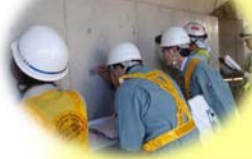
クラックスケールで ひび割れ幅を測定
