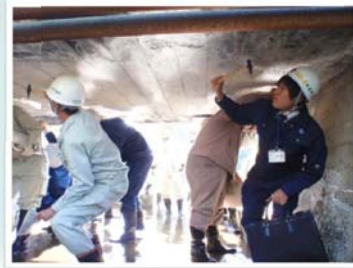
床版下面を打音検査
