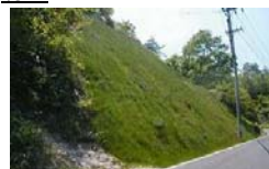
切土（のり面保護）
