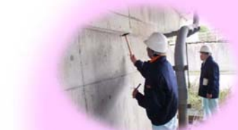
下部工打音検査
