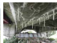
主桁のひびわれ
