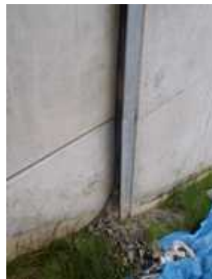
写真 土砂のこぼれ出し例
