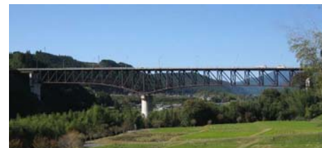
＜乙姫大橋の状況＞
