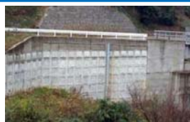
盛土（補強土壁）
