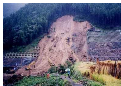
強風化・土砂化斜面での崩壊例
