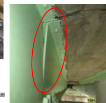
主桁の変形
