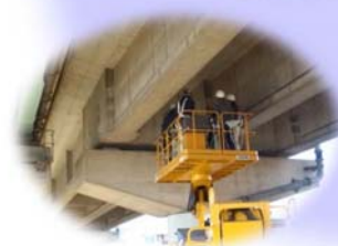
コンクリート橋の近接目視点検
