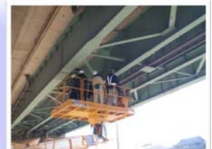
鋼橋の近接目視点検
