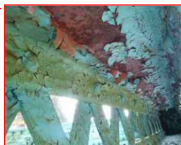
鋼材の腐食
