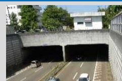
大型ボックスカルバート
