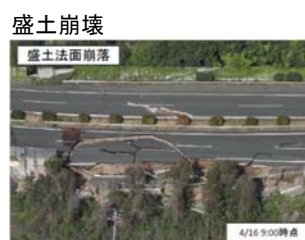
九州自動車道 益城町
