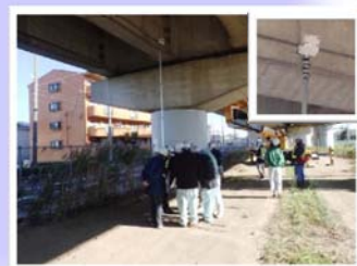
ロボットカメラを使用した高所点検
