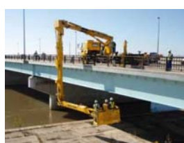
橋梁点検車による点検
