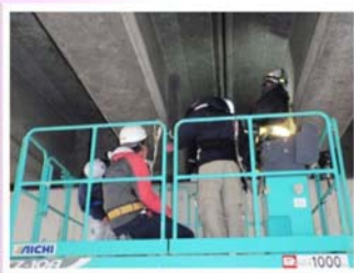
支承の損傷状態を確認
