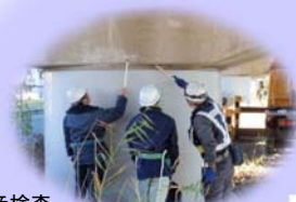
下部工打音検査
