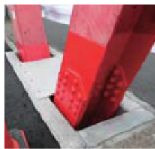
修繕後の状況(出て現場事務所にて撮影)
