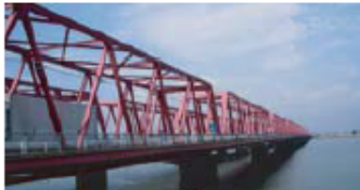
■木曾川大橋 橋長858m 1963年架設
