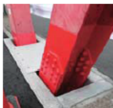
破断部の対応(右で破断部、左は修繕部)
