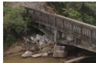
写真-2 平田・小柳線 田中橋
