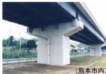
写真-3 国道3号 跨線部
