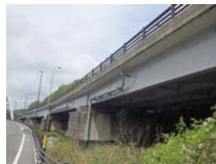
写真-4 阿蘇口大橋 (国道57号)
