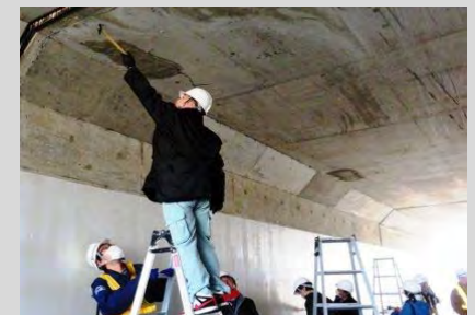
打音検査の様子(函渠)
