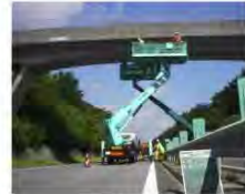
点検実施状況
