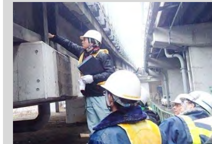
桁端部の損傷状況の確認
