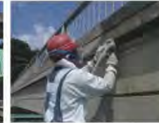
補修実施状況
