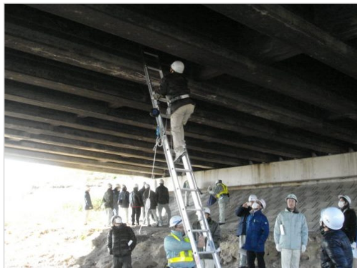
【写真】国道1号新境橋での橋梁現地点検講習会の様子
