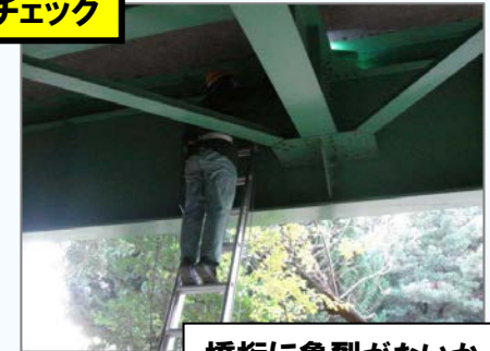
橋桁に亀裂がないか！
