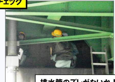
排水管のズレがないか！
