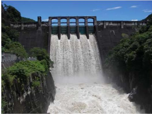
なお、ゲート操作は流入量が 2,500  $\text{m}^3/\text{s}$  以下の間は共同管理者である関西電力㈱が行い、2,500  $\text{m}^3/\text{s}$  以上となったときから丸山ダム管理所が行います。通常、流入量が 4,800  $\text{m}^3/\text{s}$  以下のときは流入量と同じ水量を放流します。
