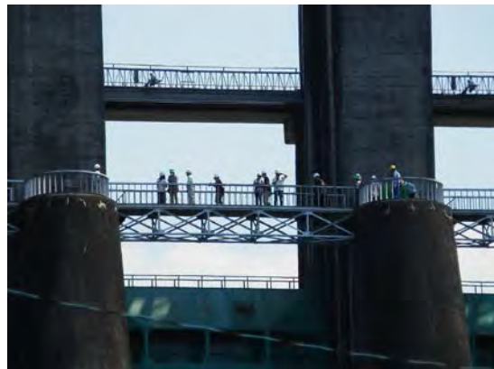
点検通路の見学(H28/8/6)
