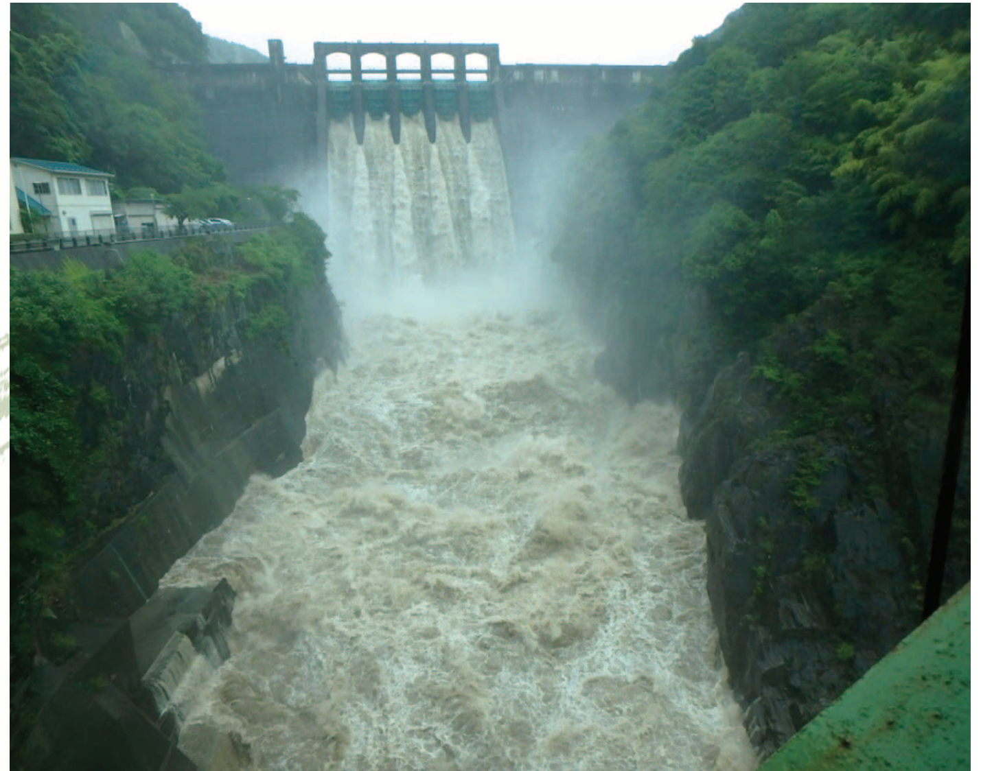
ダム放流(平成30年7月)
