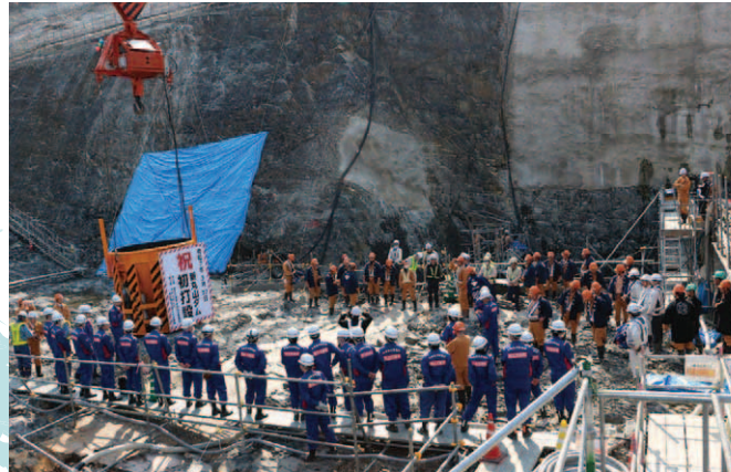
ダム本体コンクリート初打設（令和7月3日）
