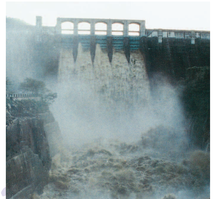
洪水吐きゲートの操作(昭和58年9月)
