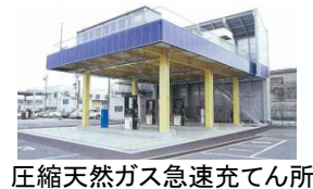
圧縮天然ガス急速充電所
