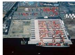
耐震岸壁整備 (名古屋港飛鳥ふ頭南側コンテナターミナル)
