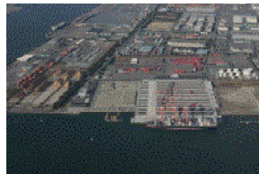
整備が進む大深水コンテナターミナル (名古屋港飛島ふ頭南側コンテナターミナル)
