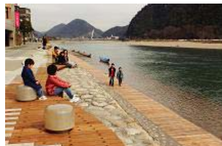
長良川右岸河畔整備
