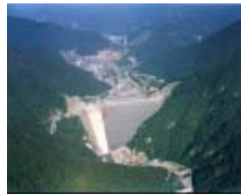
徳山ダム(平成 17 年 10 月 21 日撮影)
