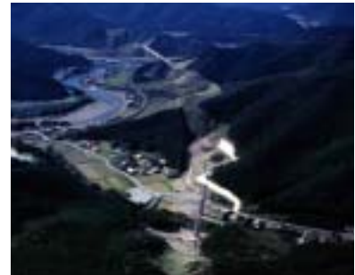
近畿自動車道紀勢線 (建設中の紀勢 IC 付近)
