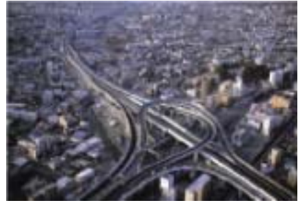
名古屋環状2号線（上社 JCT 付近）
