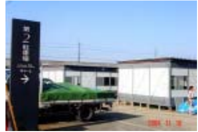
中越地震で防災拠点となった「道の駅」
