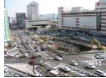
静岡駅（静岡駅前交通結節点改善事業）
